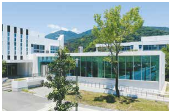
図書館棟 外観
